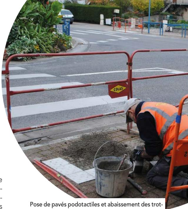
Pose de pavés podotactiles et abaissement des trottoirs Grande Rue. Ces bandes ont pour but d'alerter d'un danger et de sécuriser les déplacements des personnes aveugles ou malvoyantes dans les zones comportant des obstacles.
